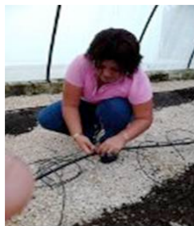
Figura 8. Instalación de goteros
