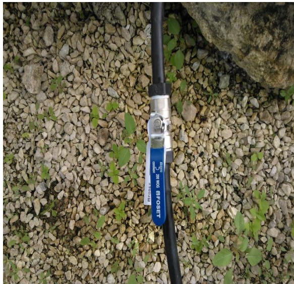
Figura 8. Instalación de llaves de paso.
