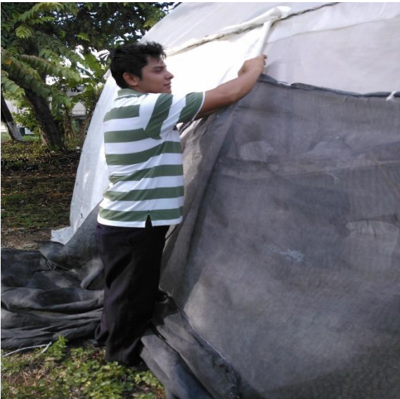
Figura 7. Instalación de la malla sombra
