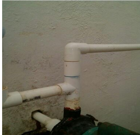
Fig.3 Instalación de Sistema Hidraulico
