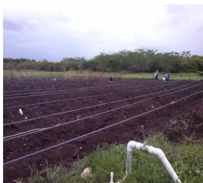
Figura 7. Instalación de sistema de riego
