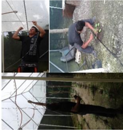
Figura 9. Instalación del sistema de tutoreo.
