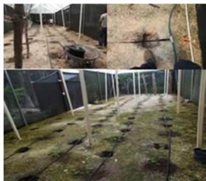
Figura 8. Instalación del sistema de riego.
