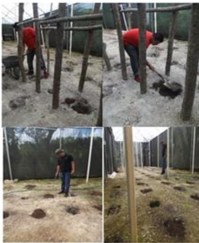
Figura 6. Preparación del terreno.
