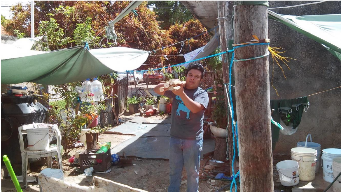
f) Cargando los palos que se ocuparon en la estructura del techo.
