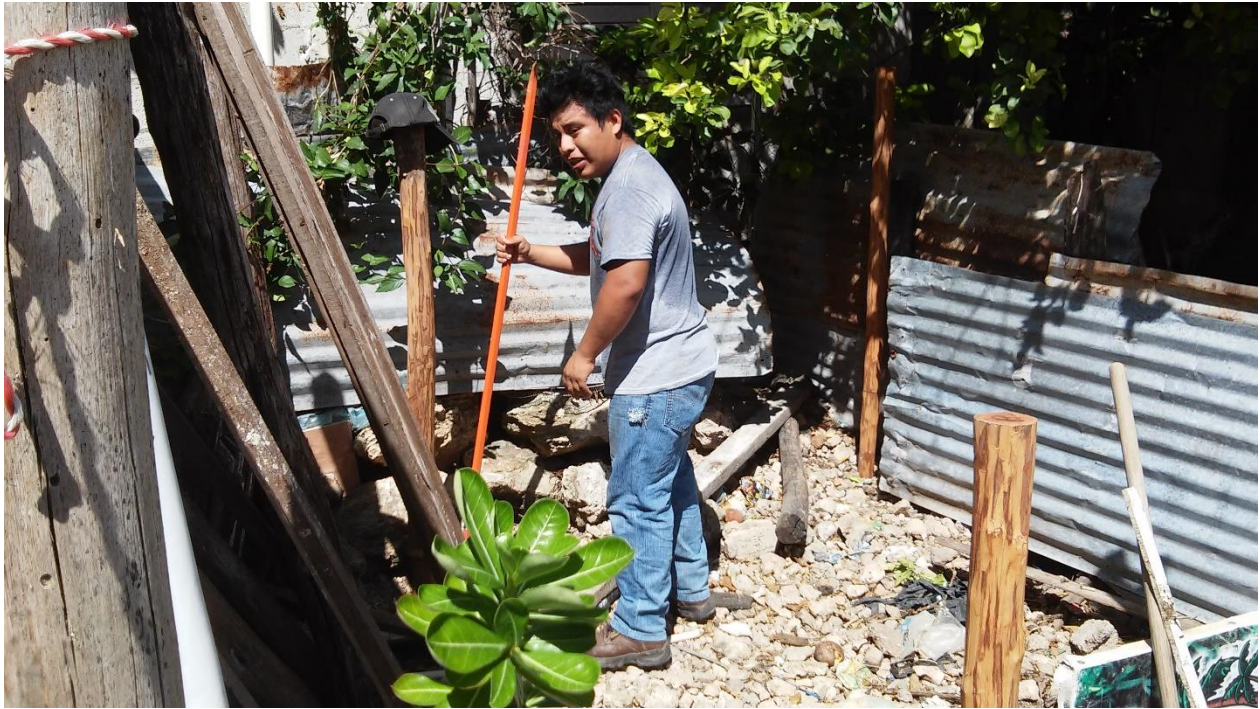
d) Trabajando en los cimientos para el resto de la estructura
