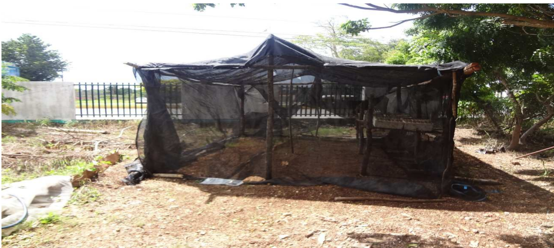
Fig. 2. Etapa final de la construcción del invernadero para el protocolo de investigación.
