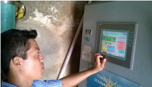
Cuadro 5: panel de control del secado de la madera.
