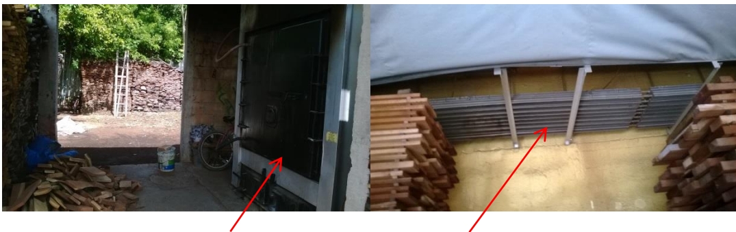
Cuadro 4: caldera de calentamiento. Distribuidores de calor.
