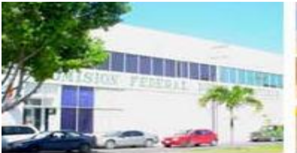
Figura 2. Imagen de las Oficinas de la CFE en Plaza Caracol, Zona de Distribución Chetumal
