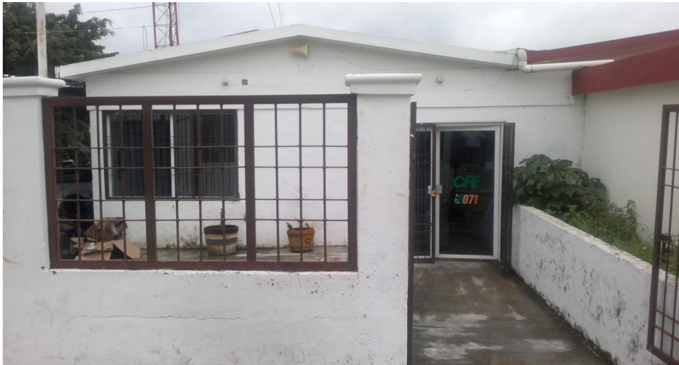
Figura 6. Imagen de las Oficinas de la CFE en Bacalar, Zona de Distribución Chetumal
