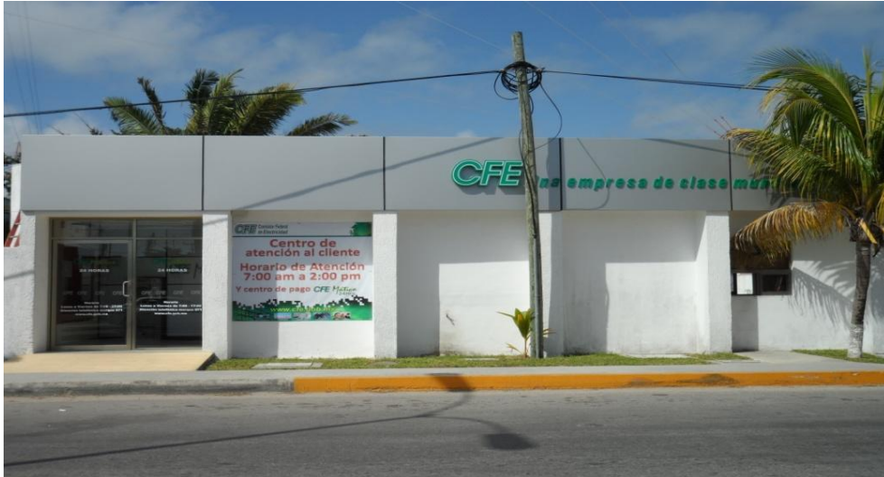
Figura 3. Imagen de las Oficinas de la CFE Centro de Distribución, Zona de Distribución Chetumal
